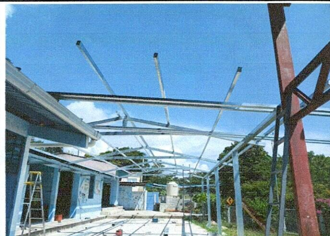
Foto 1: Instalación de estructura de techo tipo portico y cubierta de lamina calibre 26
